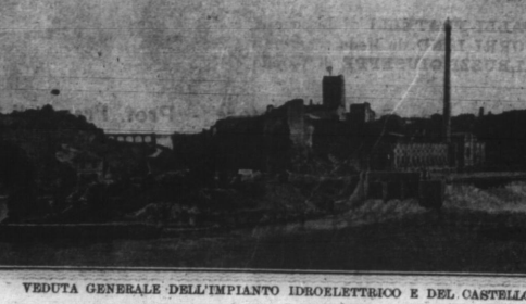
VEDUTA GENERALE DELL'IMPIANTO IDROELETTRICO E DEL CASTELLO
