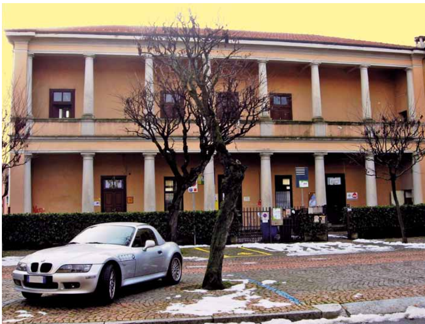
Fig. 3 - Giuseppe Zoja , fronte dell'edificio scolastico di piazza Crivelli realizzato, 1898. A.C.T.
