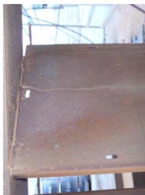
CAMPIONE – Lamiere in corten assemblate per realizzare i gradini di una scala
