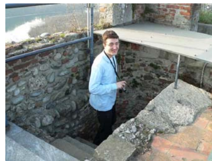
Apertura esistente per l'accesso in sommità
