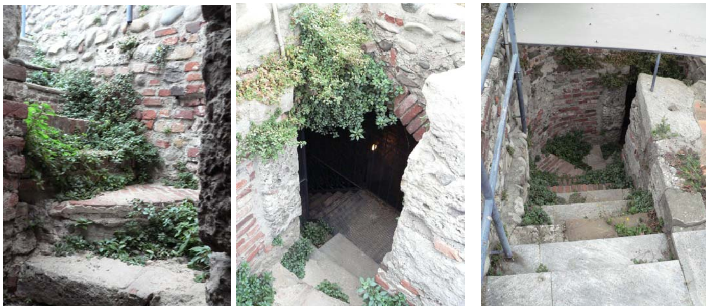
Apertura esistente e scala in pietra di accesso alla sommità
