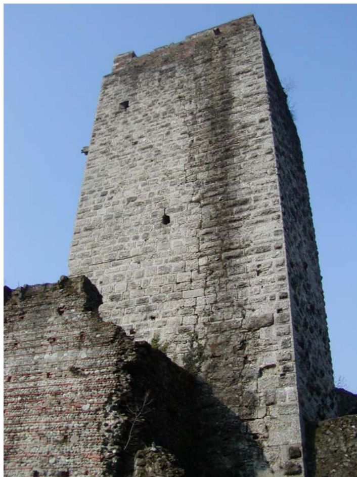
Vista nord-est della Torre
