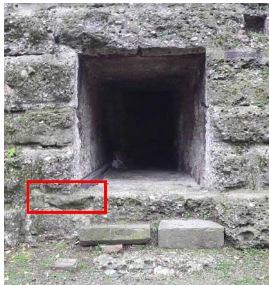
Blocco granitico per equilibrare il dislivello dello zoccolo in Ceppo d'Adda, in prossimità dell'ingresso
