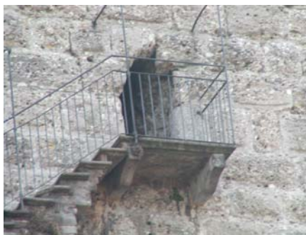
Apertura esistente per l'accesso allo spalto
