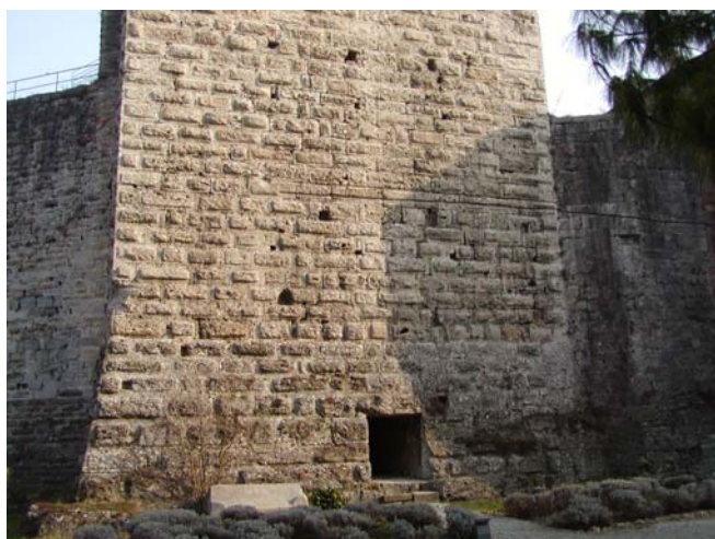
Ingresso al piano terra alla Torre, situato sul lato sud
