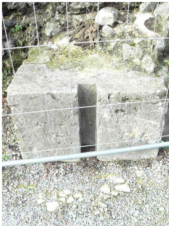
LATO EST - Particolare della sede dell'antico ponte levatoio
