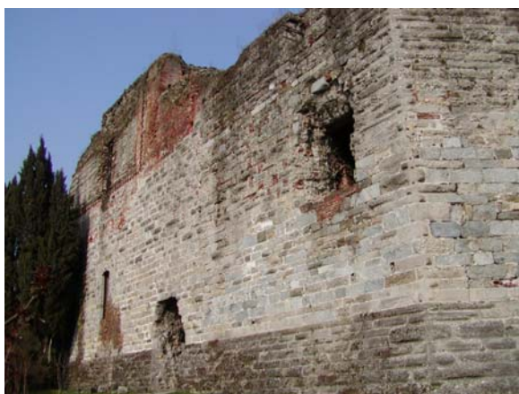
Tessitura muraria mista (mattoni e Ceppo d'Adda) del lato sud-est dello Spalto
