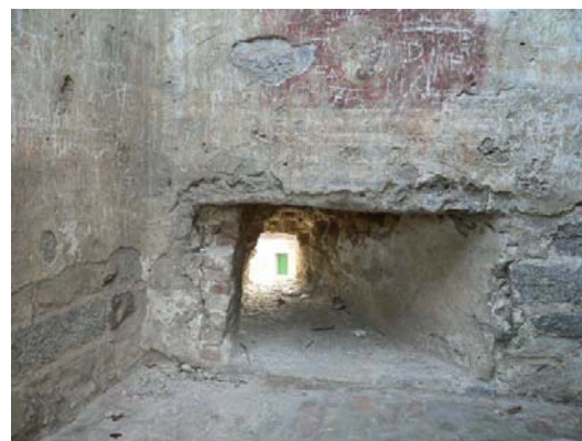
PARTICOLARE DEL DEGRADO – Tracce di decorazione pittorica ad affresco, quasi completamente dilavata
