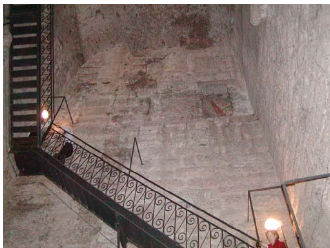
Vista interna della Torre
