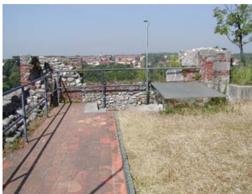
Sommità della Torre con tettoia in plastica di protezione per la scala
