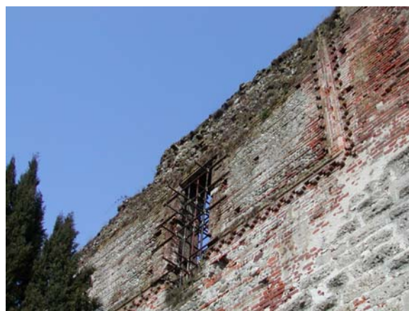
Particolare tessitura muraria mista (mattoni e Ceppo d'Adda) del lato sud-est dello Spalto
