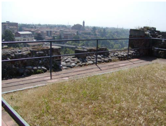
Sommità della torre
