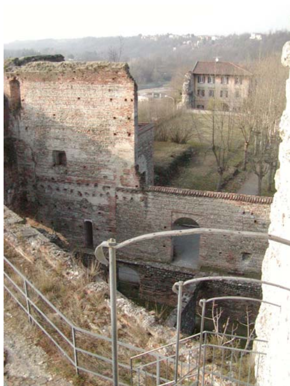
LATO OVEST – Vista dall'alto
