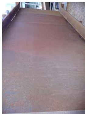
CAMPIONE – Lamiere in corten assemblate per realizzare i gradini di una scala
