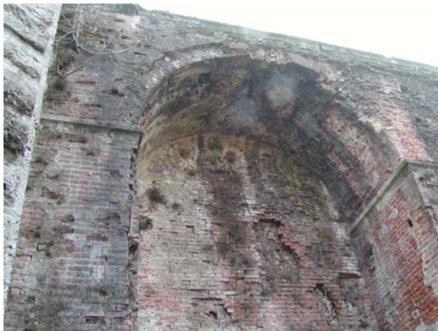
Particolare della volta a botte in muratura di mattoni
