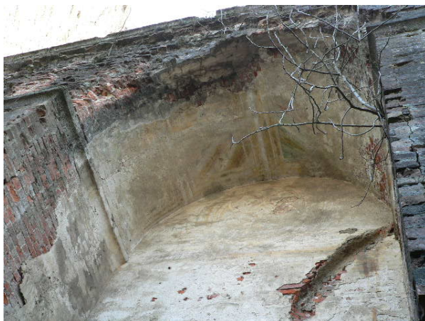
Particolare dell'intonaco decorato presente all'intradosso della volta a botte del nicchione
