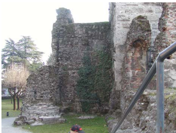
LATO EST - Vista nord della Posterla
