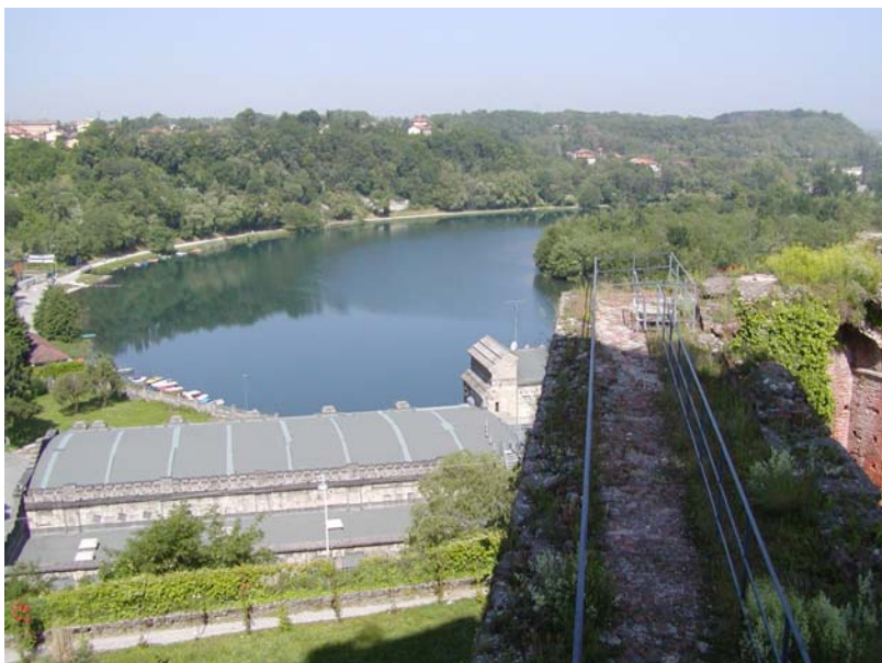
LATO OVEST – Vista dello Spalto dall'alto
