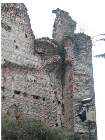
LATO OVEST – Particolare rudere
