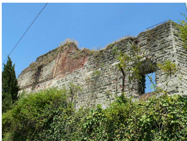
LATO OVEST – Muro contiguo allo Spalto
