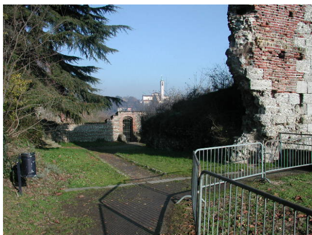
LATO EST - Ruderì transennati
