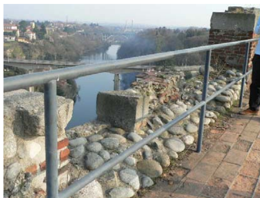
Parapetto in ferro sulla sommità della Torre
