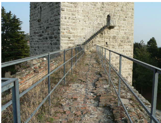
Apertura esistente sul lato ovest di collegamento allo spalto esterno
