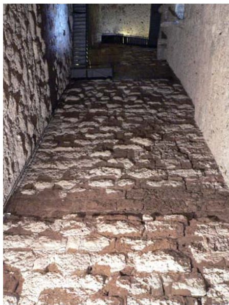
Vista interna della Torre
