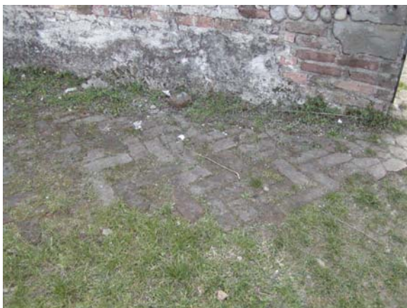
Traccia della posa dell'antica pavimentazione a spina di pesce, su letto di malta a base di calce
