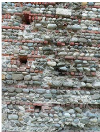
Tessitura muraria caratterizzata da file di ciottoli, alternate con laterizi
