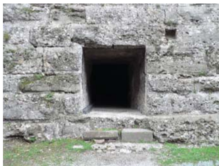
Apertura esistente per l'accesso al piano terra
