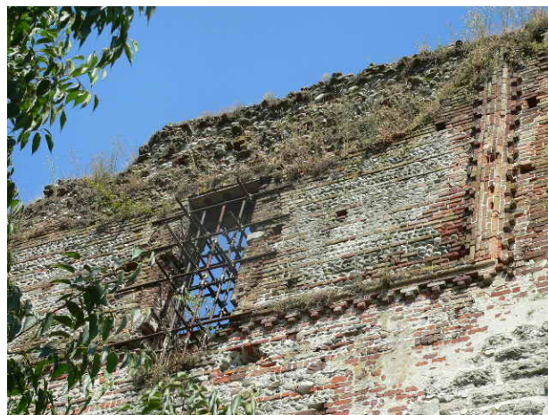
LATO OVEST – Particolare rudere
