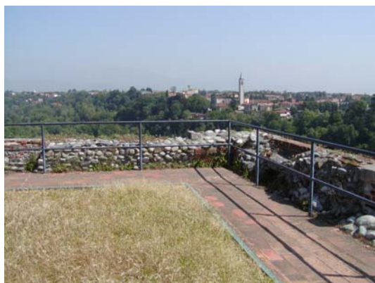
Sommità della Torre
