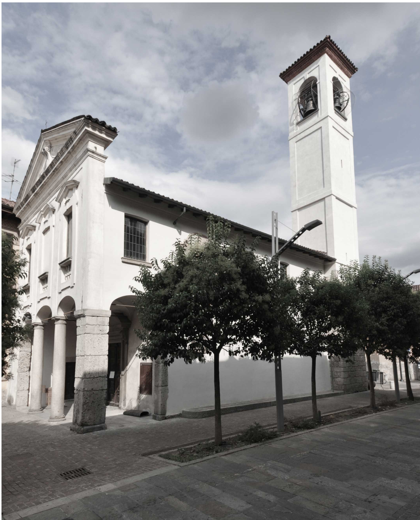
figura 2: l'Oratorio di San Rocco dopo i restauri del fronte sud e della torre campanaria
