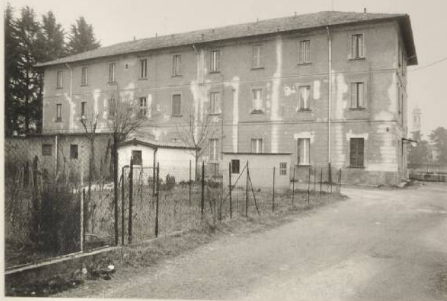
edificio ex Collegio Mariani (1870) in via Galli: prospetto verso l'abitato
