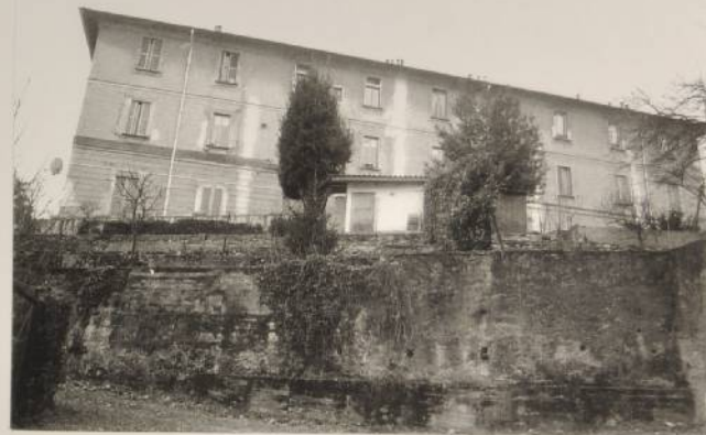
edificio ex Collegio Mariani (1870) in via Galli: prospetto verso il fiume
