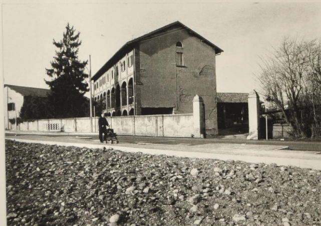
1 - Cascina in via Cavour: fronte nord-est
