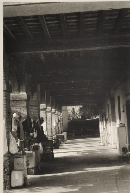
1 - Cascina in via Cavour: particolare del portico
