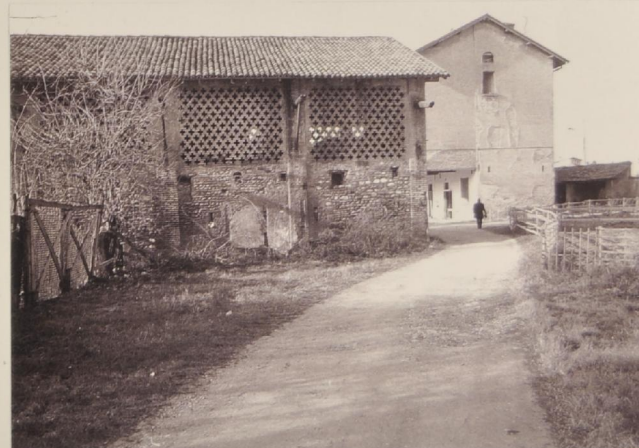
2 - Cascina in via Cavour: particolare del fienile
