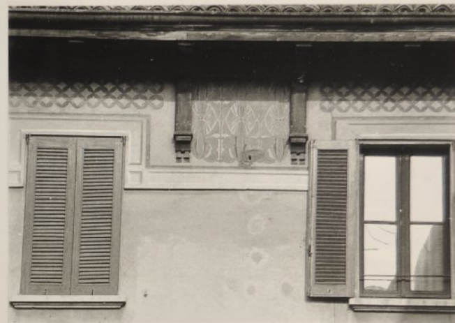
2 - Edificio liberty: particolare del fregio sottogronda
