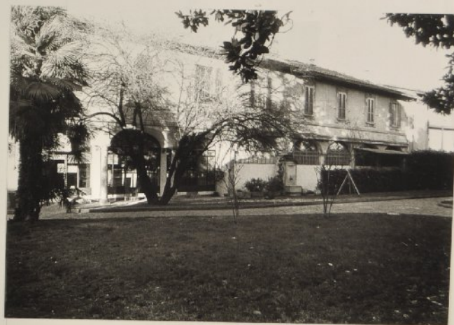
11 - Casa Biffi: fronte su via Biffi
