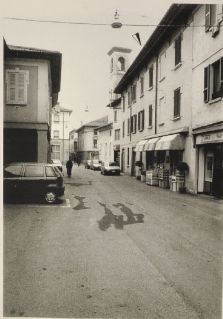
6 - Fronte dell'edificio in piazza della Libertà ai civici n. 32/34
