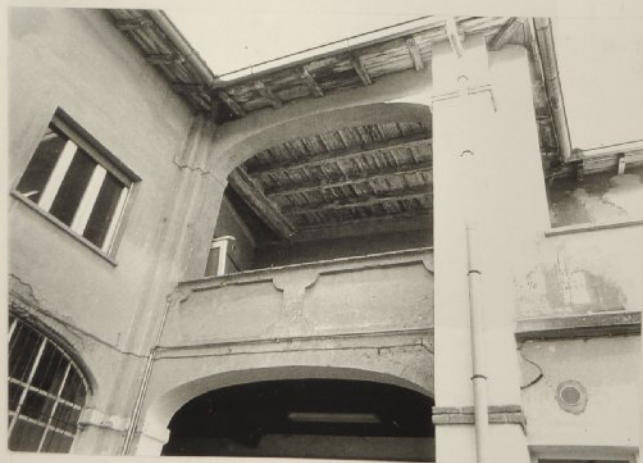
14 - Edificio di via Torre al civico n° 17: loggiato settecentesco con copertura a passasotto
