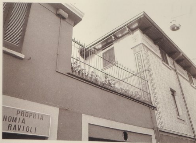
1 - Edificio d'angolo: particolare sul terrazzo di via Torre
