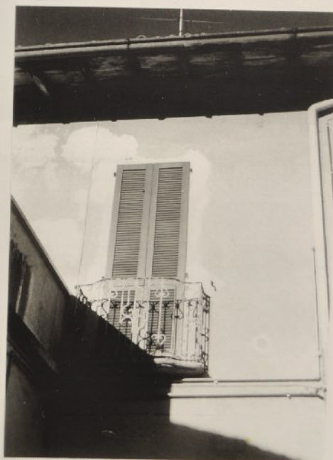
15 - Edificio di via Torre al civico n° 17: particolare del poggiolo sul cortile
