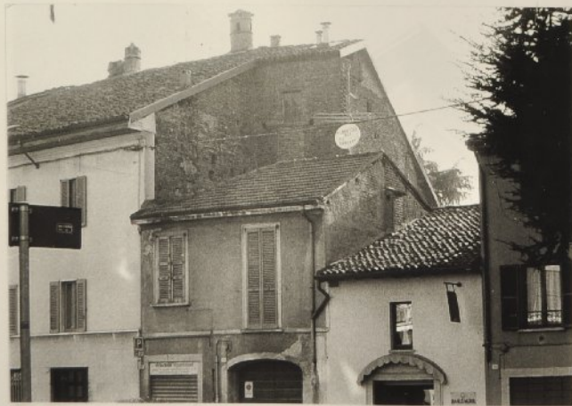
1 - Particolare dei tetti
