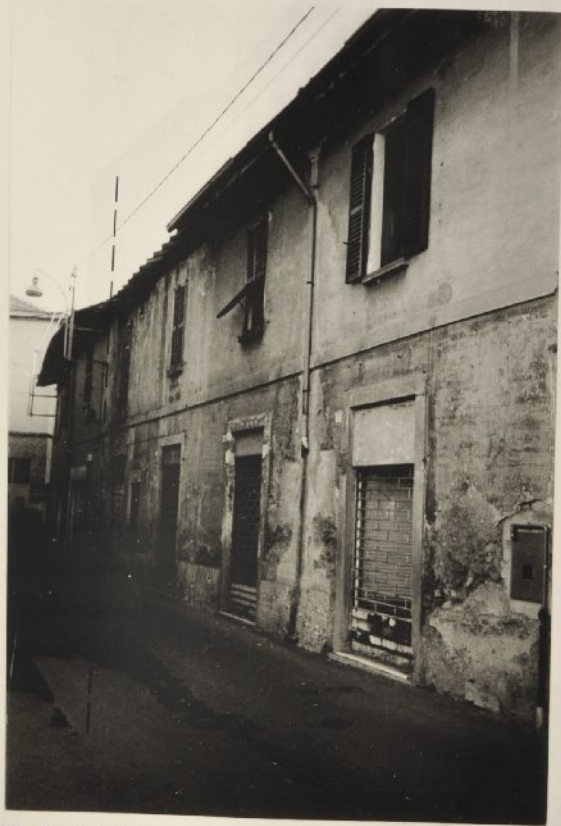
8 - Fronte dell'edificio di via S. Caterina dalla casa precedente al civico n° 15
