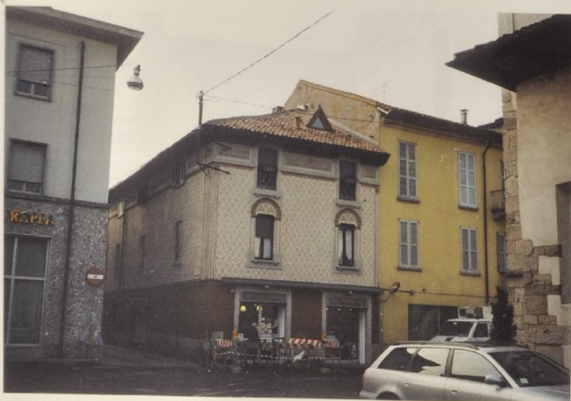
1 - Edificio d'angolo tra piazza della Libertà e via Torre
