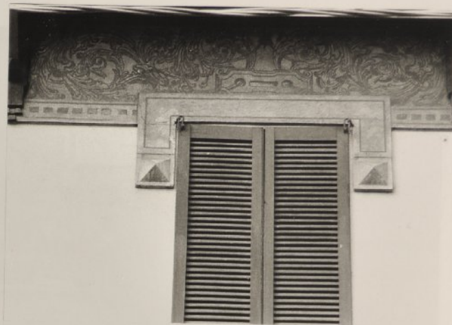
6 - Fronte dell'edificio in piazza della Libertà ai civici n. 32/34: particolare del fregio sottogronda
