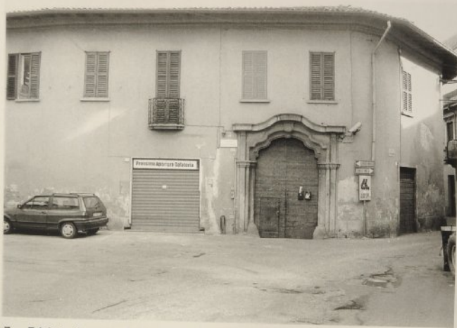
7 - Edificio di piazza della Libertà al civico n° 52, già casa Valvassori, sec. XVII: fronte su piazza della Libertà
