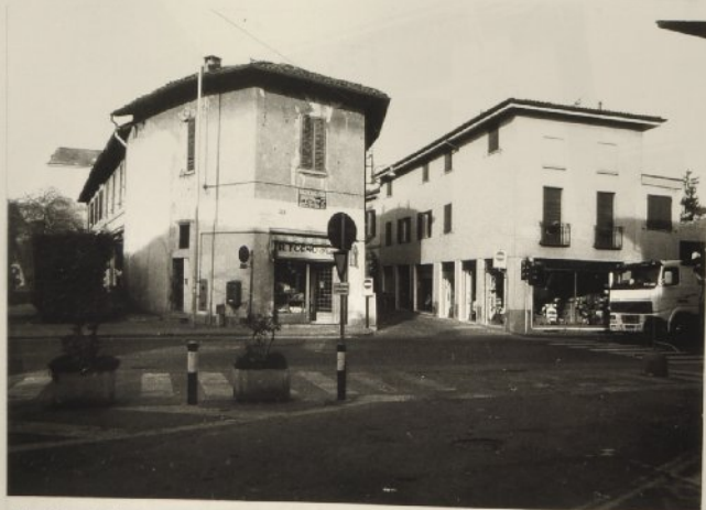
11 - Casa Biffi: fronte su via Biffi
