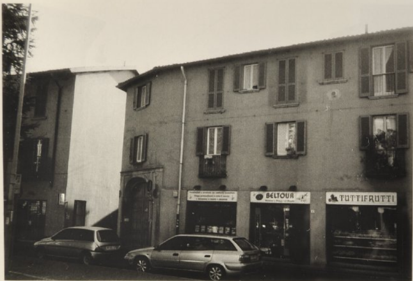
1 - Cortina in piazza della Libertà da via Jacopo da Trezzo e risolto su via Torre: particolare
