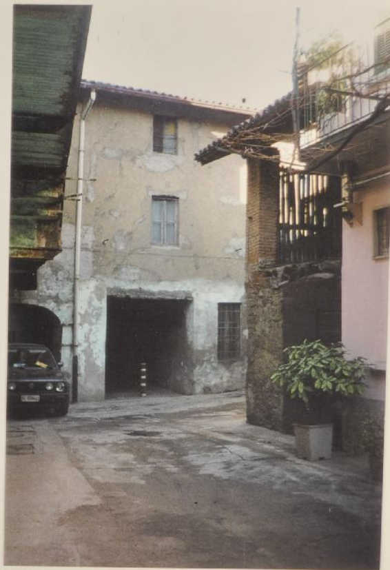
22 - Casa masserizia Cavenago: cortile
