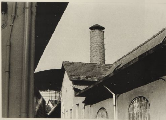
3 - Opificio ex Baghetti: particolare della ciminiera
