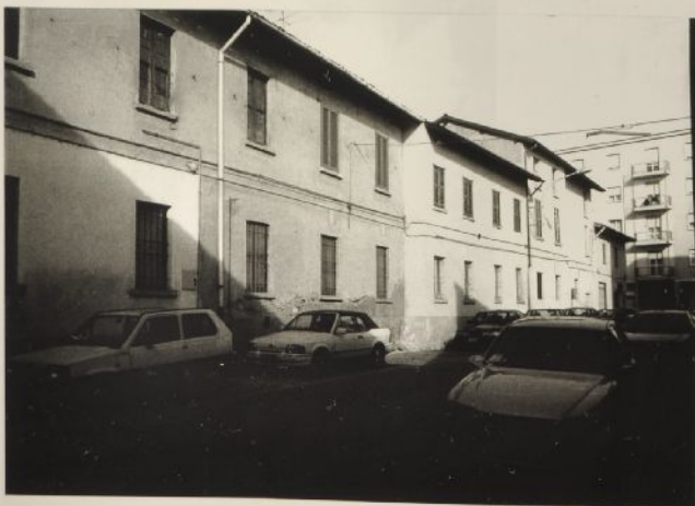
8 - Cortina di edifici sul fondo chiuso di via Jacopo da Trezzo
