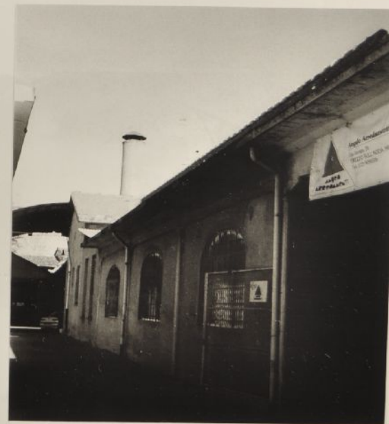
2 - Opificio ex Baghetti: prospetto interno del corpo adiacente via S. Marta
