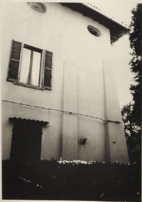
9 - Casa Melzi: particolare dei contrafforti
