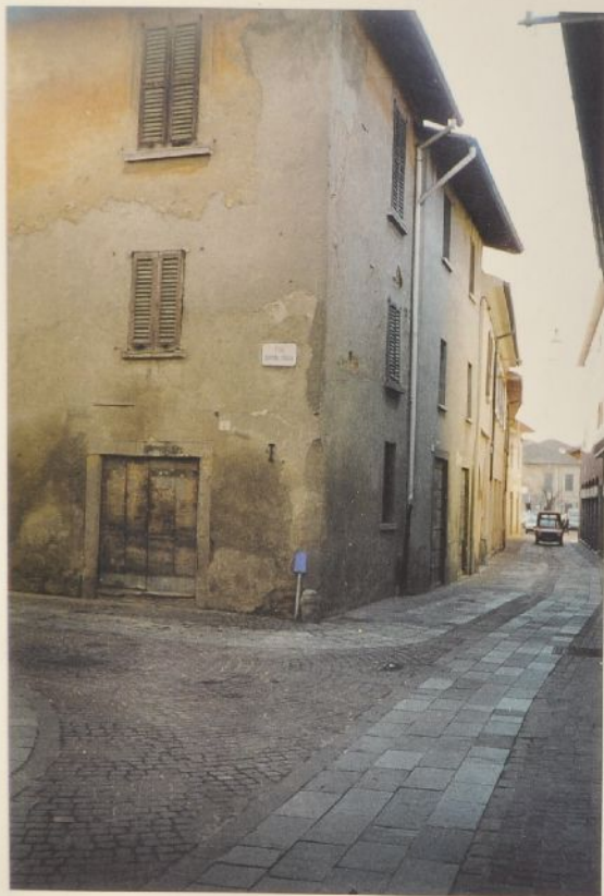
22 - Casa masserizia Cavenago, sec. XVII
