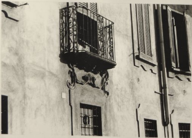
18 - Edificio in via S. Marta n. 21: particolare del secondo poggiolo
