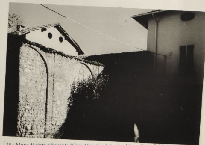
10 - Muro di cinta adiacente "Casa Melzi" sul fondo chiuso di via S. Marta
