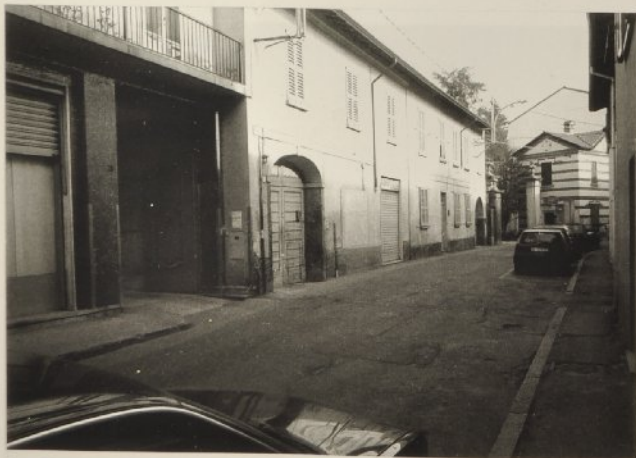
8 - Fronte sulla via Dante della casa ai civici n.18/26
