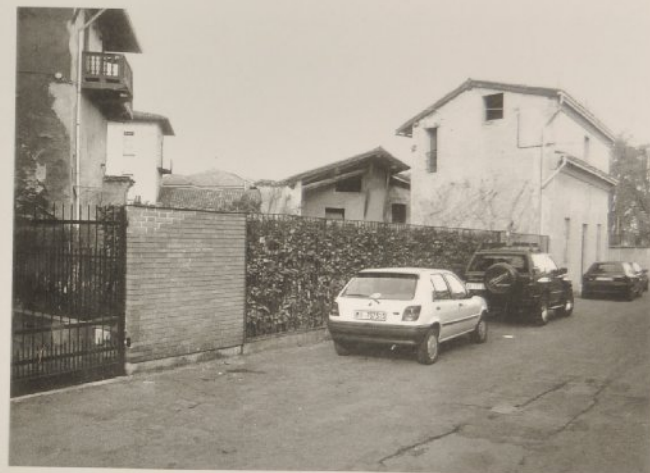
16 - Casa Bassi: rustici
