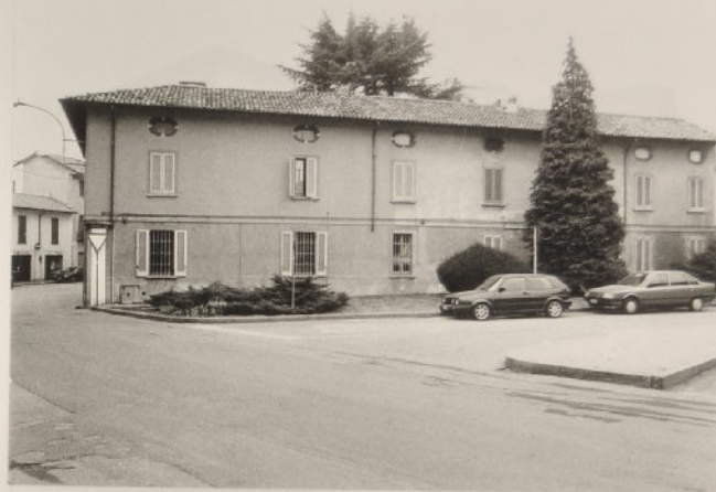
10 - Edificio a due piani, ex Convento di S. Bartolomeo: fronte su via Roma
