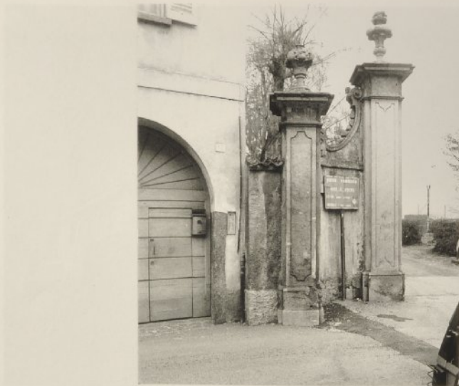
7 - Particolare dell'essedra e dell'ingresso
