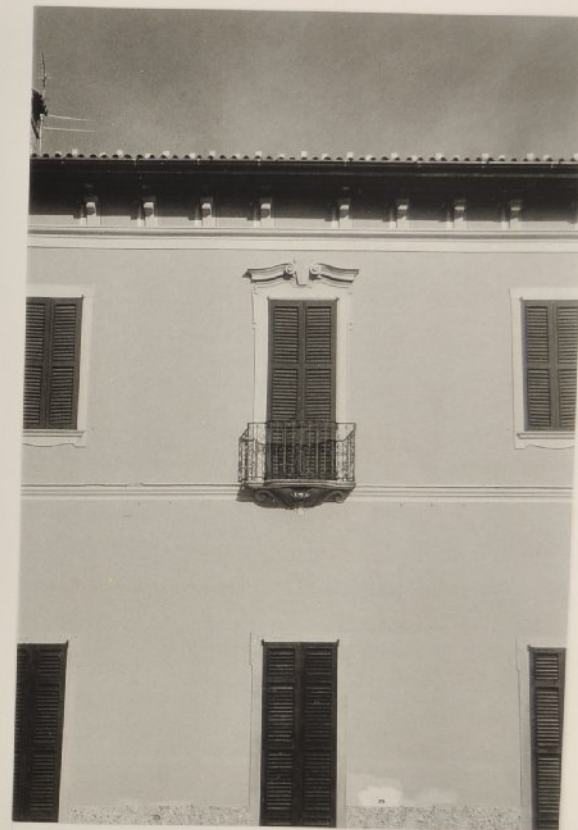
1 - Villa Comunale: particolare del poggiolo della fronte sul viale d'accesso
