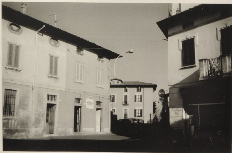
10 - Edificio a due piani, ex Convento di S. Bartolomeo: fronte su piazza S. Bartolomeo
