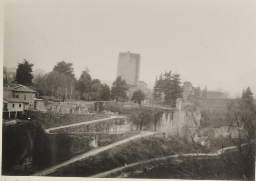
1 - Castello Visconteo: veduta dal ponte
